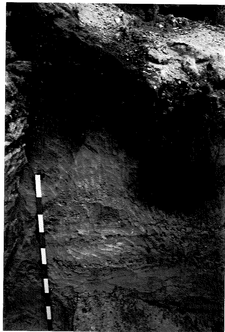
Vue du comblement sableux d'une partie des tranchées de fondation
